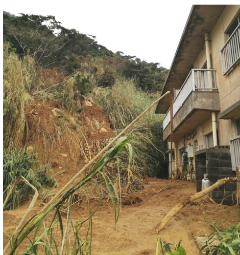
10号の後土砂崩れした 本窯教員住宅裏
