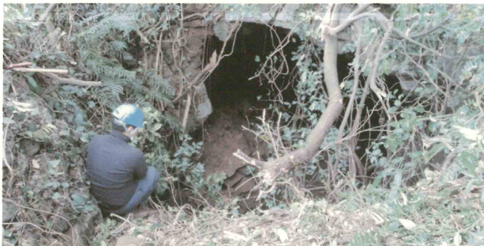
図5 陥没地点の除草作業
