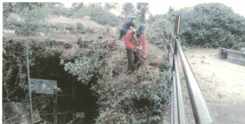
図4 井坑における清掃作業
