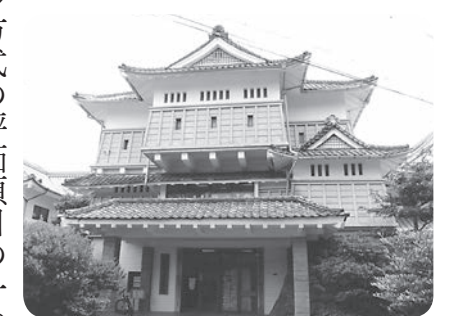
老朽化が進む現在の図書館
