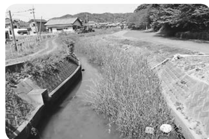
護岸改修予定の田部手川
