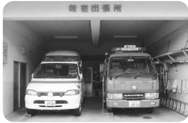
昭和48年に建設された岐宿消防出張所
