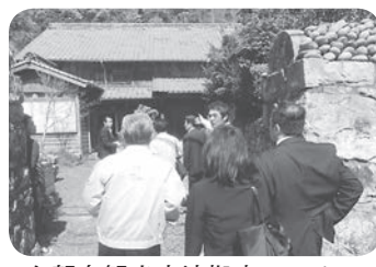
久賀島観光交流拠点センターとして改修予定の古民家
