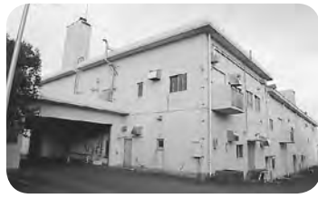
福江衛生センター
