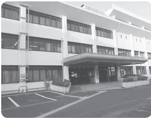
市役所本庁舎本館棟
