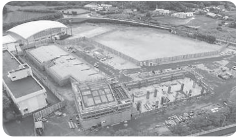
建設中の岐宿地区統合小学校
