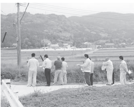
福江17号線（鳴木場橋）
