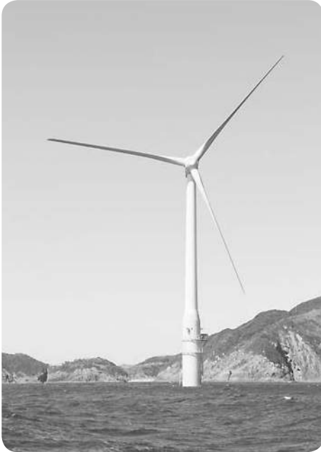
浮体式洋上風力発電実証機
