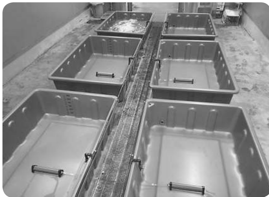
魚市への活魚水槽の設置
