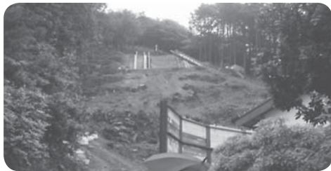
岐宿町小川原地区の急傾斜地崩落対策事業で山膚を削って、法枠工事の準備をしているところ
