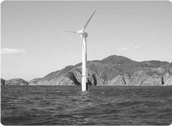
椏島沖の浮体式洋上風力発電
