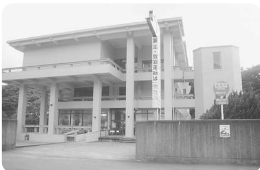
奈留地区避難所 離島開発総合センター
