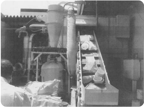
廃プラ油化還元装置
