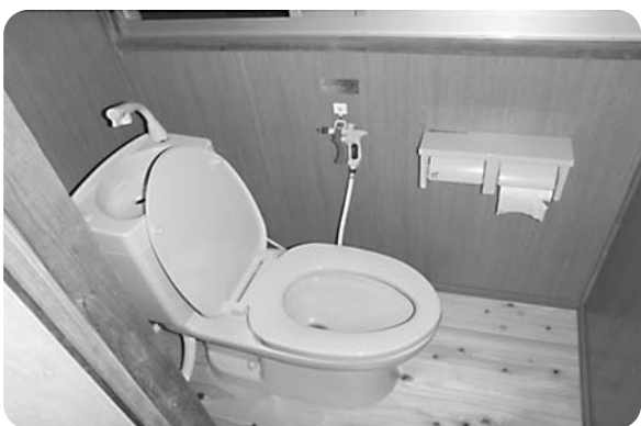
簡易水洗トイレ設置後の教職員住宅
