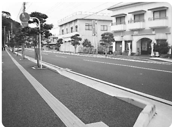
排水機能を持つ舗装工事を行った福江富江線
