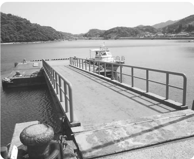
改修予定の奥浦港浮棧橋
