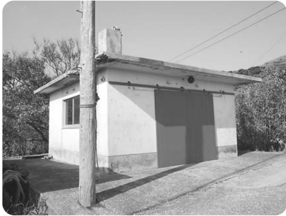
嵯峨島の消防格納庫
