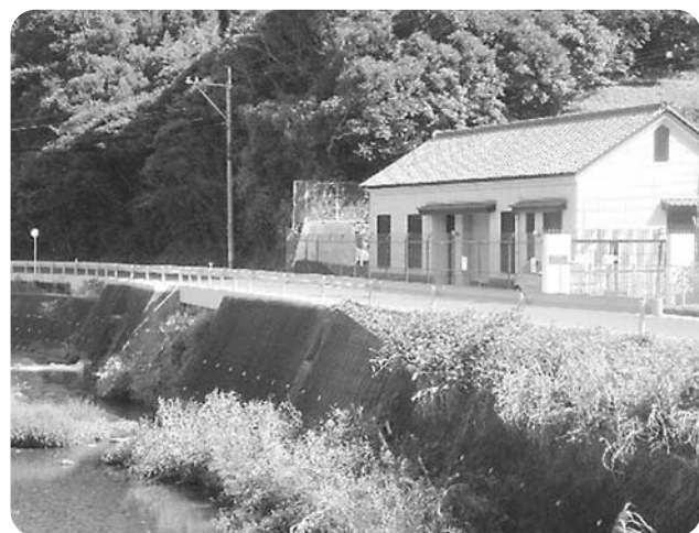
水力発電している九州電力鰐川発電所
