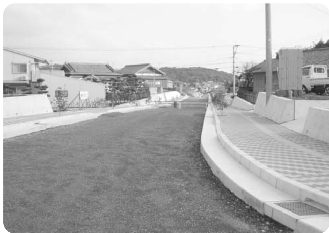
建設中の都市計画道路
