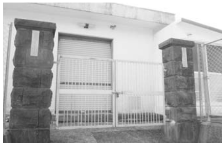
濁度監視装置設置予定の京ノ嶽水源地
