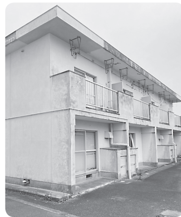
奈留小中学校の教職員住宅
