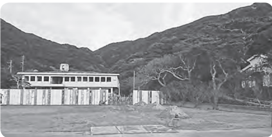
解体工事中の旧江上小学校
