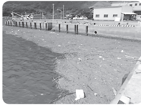
豪雨で漁港に漂着した大量の流木
