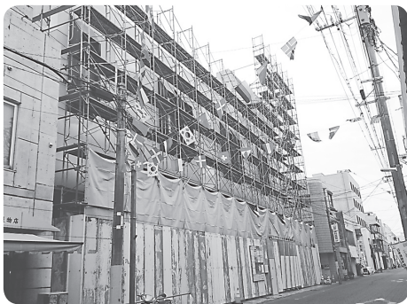
解体工事中の福江ショッピング
