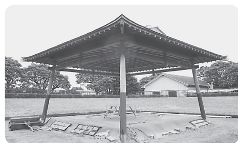
跡地にテニスコート2面を整備予定の屋外相撲場
