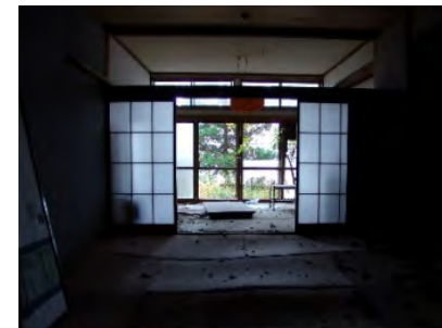
老朽化したホテル・旅館の改修
