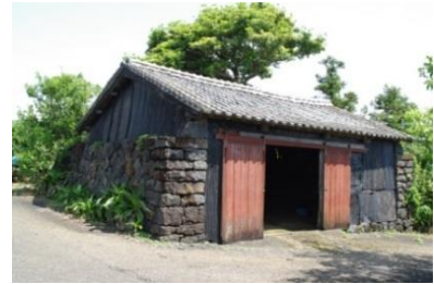
写真E-42 倉庫
