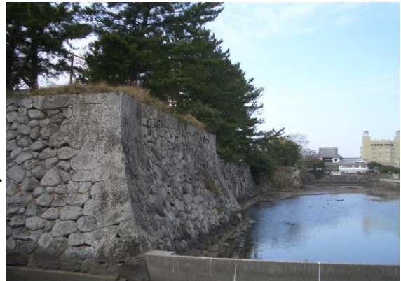
写真 E-37 石田城の石垣
