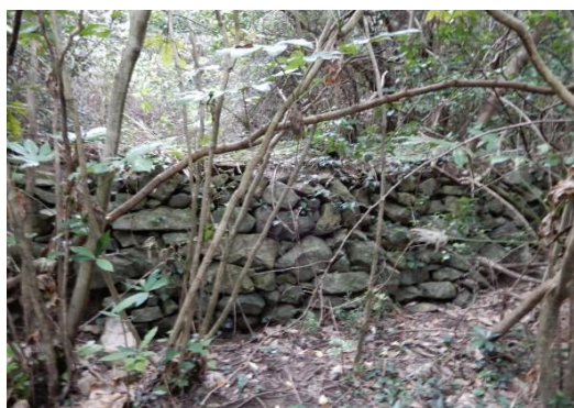
図4-14 段々畑の土留めの石積み
