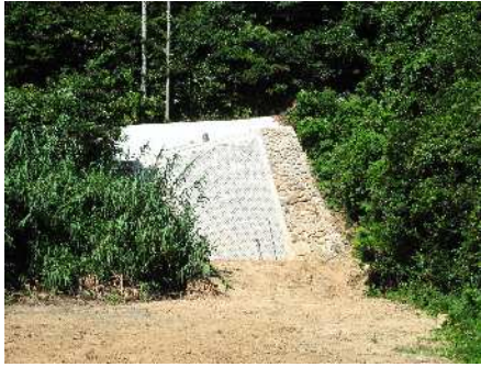
間知ブロックによる復旧
