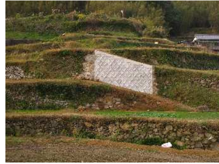
間知ブロックによって連続性を失った 石積景観
