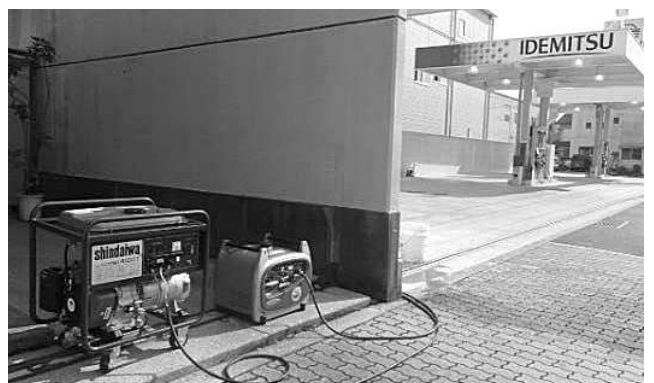
災害対策で自家発電機を整備
