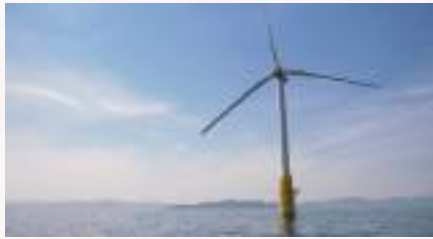
崎山沖の浮体式洋上風力風車
