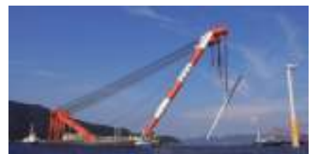
3,700t吊起重機船「第50吉田号」
