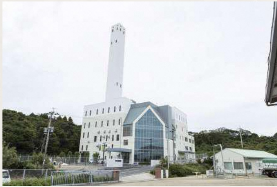
五島市クリーンセンター本格稼働
