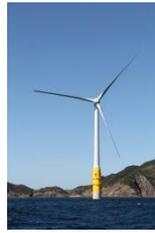
風車は全長172m、海面からの高さは羽根も含めて約100m。羽根だけだと40mになります。2年間運転し、発電効率や環境への影響を調べます。
