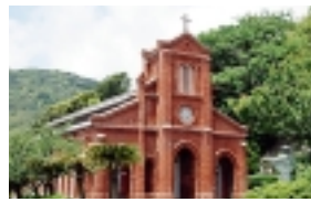
堂崎教会 1879年創建 / 1908年改築。海辺に佇む堂崎教会は、明治6年禁教令解禁後五島に初めて建てられた天主堂
