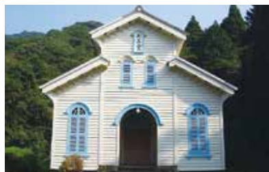
奈留島の江上集落(江上天主堂)【世界文化遺産構成資産】 教会建築の名工鉄川与助の代表作。日本の木造教会のうち、完成度の高い作品として歴史的価値が高い。
