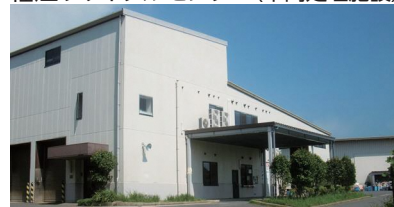
福江リサイクルセンター(中間処理施設)
