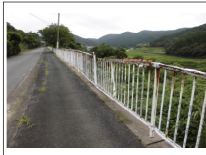
状況写真（遠景）
