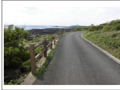
状況写真（遠景）
