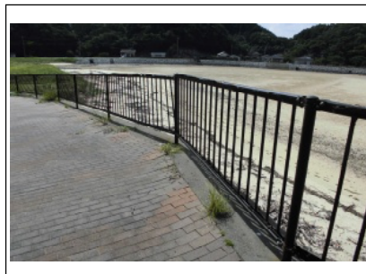
状況写真（遠景）
