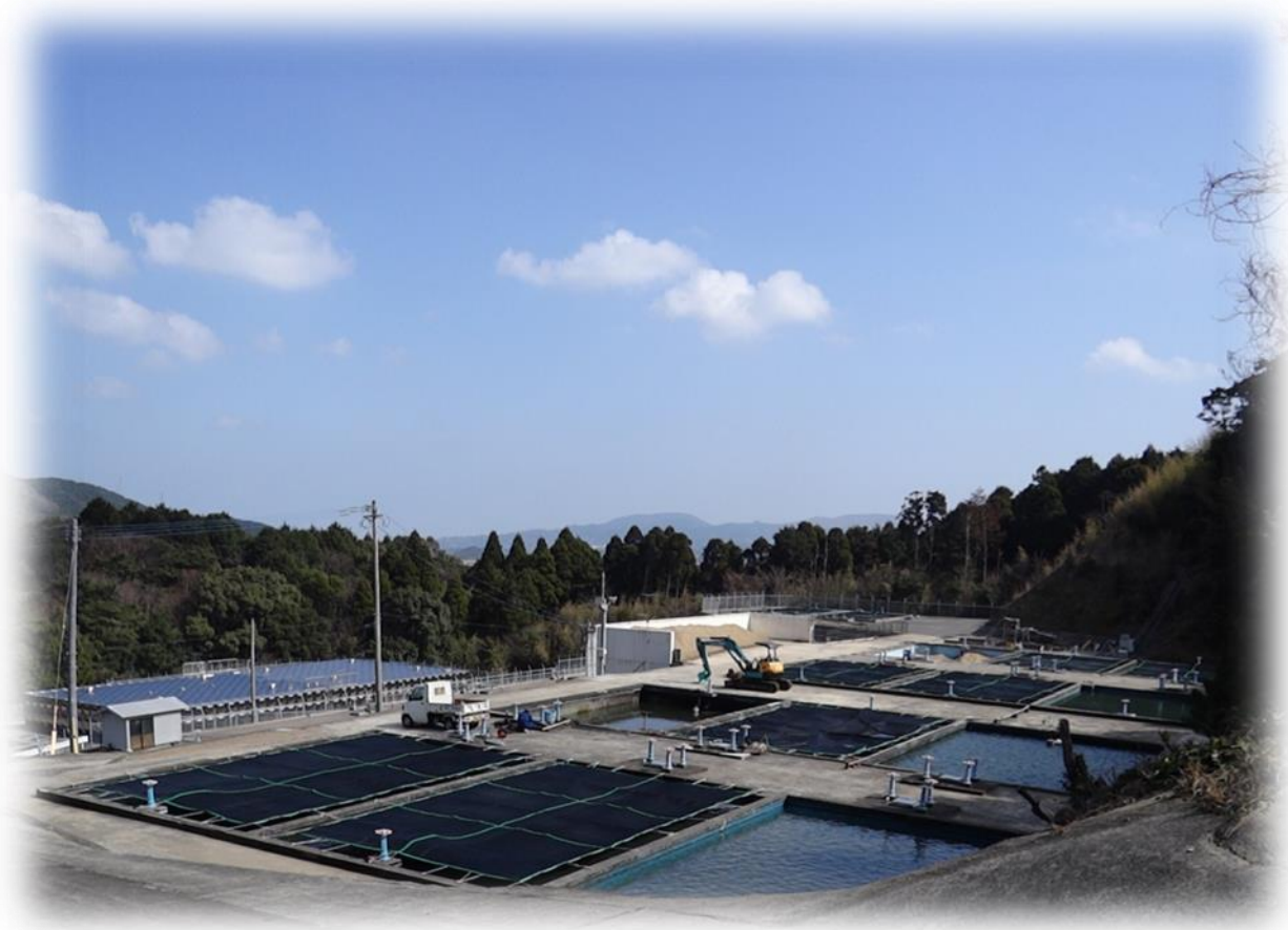
福江地区：籠淵浄水場
