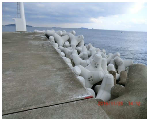
ブロック設置状況
