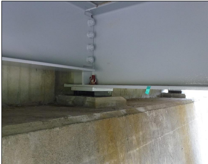
固定側支承、主桁、横桁取付け状況（A1側）
