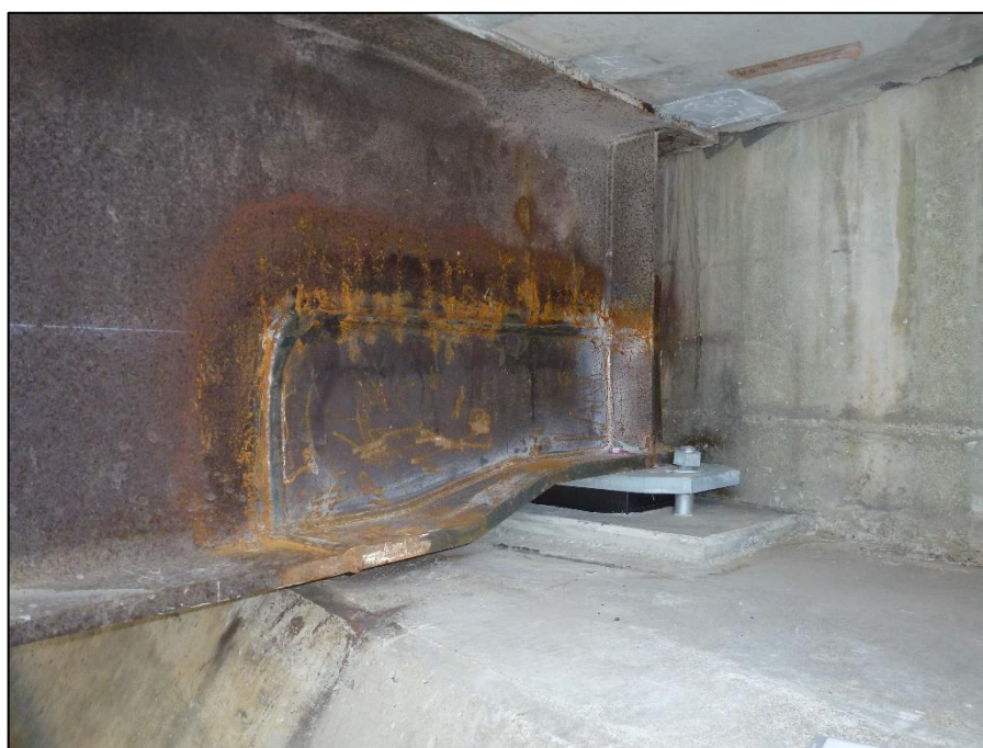
鋼桁溶接補強箇所及び支承設置状況（A2側）
