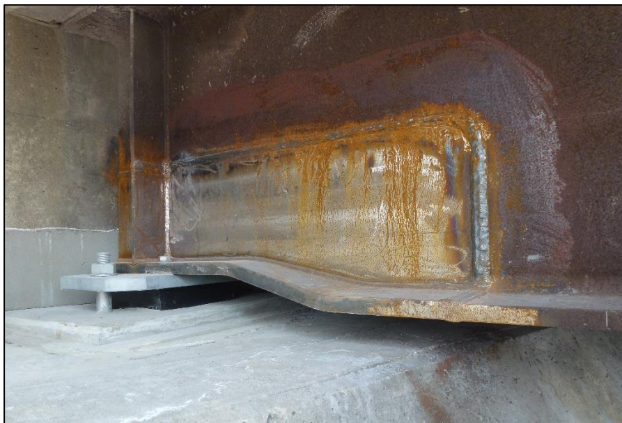
鋼桁溶接補強箇所及び支承設置状況（A1側）
