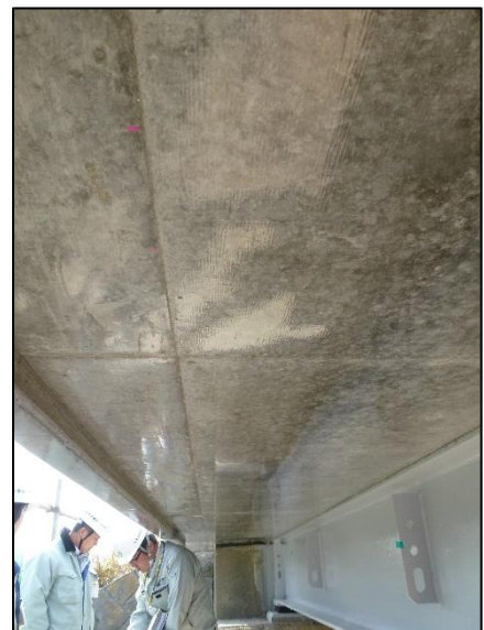
床板コンクリート仕上り状況（左：中央部、右：張出し部） （コンクリート表面の仕上がりは滑らか且つ密実である）
