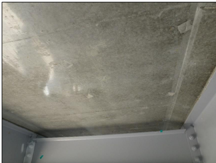
床板コンクリート仕上り状況（左：中央部、右：張出し部） （コンクリート表面の仕上がりは滑らか且つ密実である）
