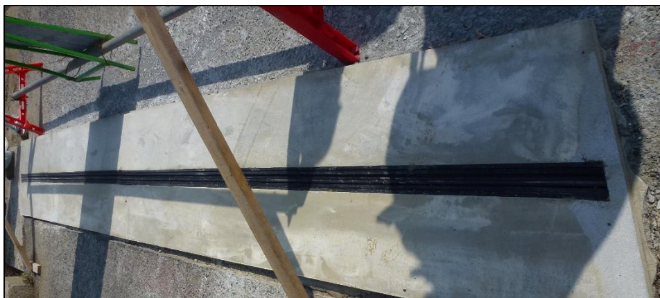
伸縮装置設置状況
