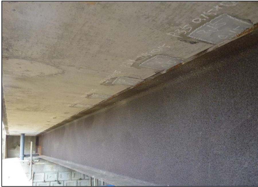
床板補修状況
