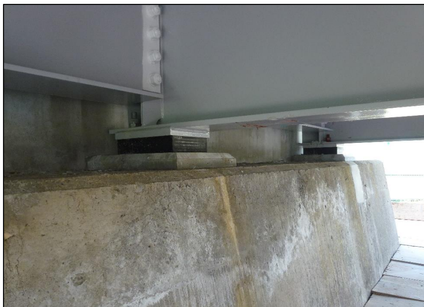
可動側支承、主桁、横桁取付け状況（A2側）
