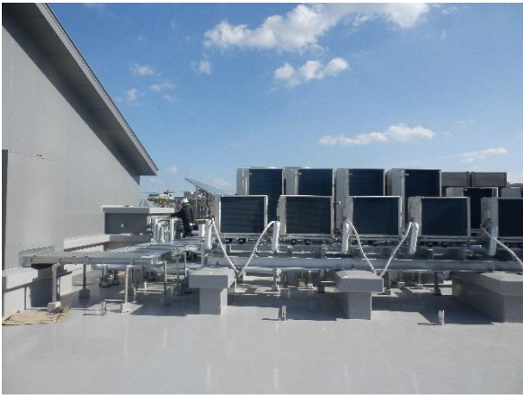
写真 6 屋上設備機器据付状況
