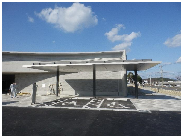
写真2 監査当日の現場外観
