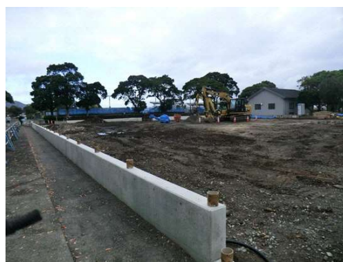
擁壁工 (支柱箱抜)
