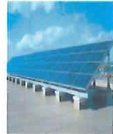
架台方式の太陽光発電パネル
