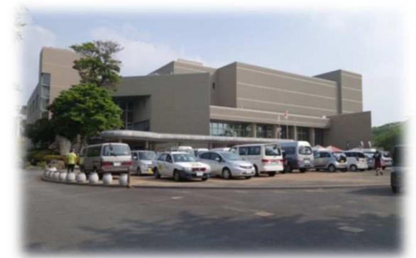
左側の建物が勤労福祉センターで、右側が福江文化会館です。
