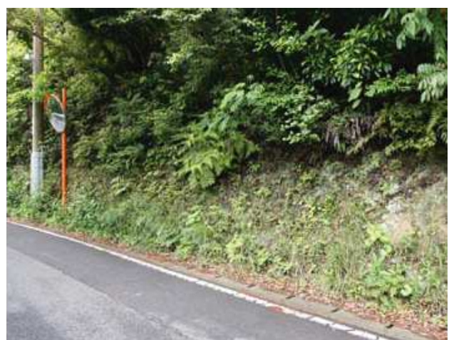
道路建設のための石積み
