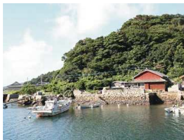
海岸の護岸の石積み
