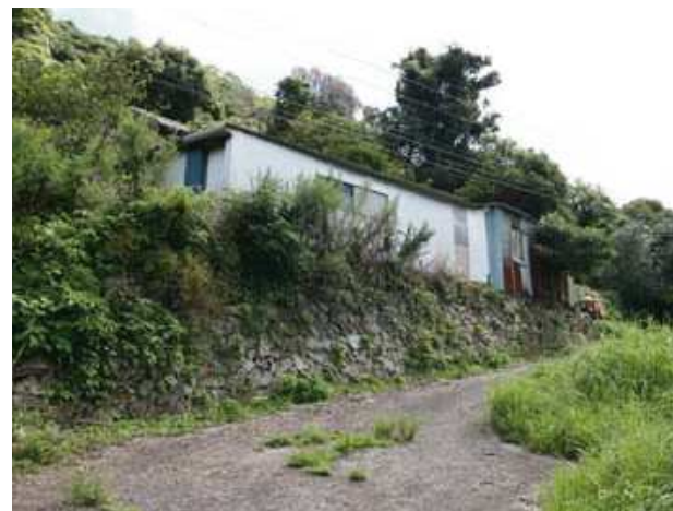
宅地造成のための石積み
