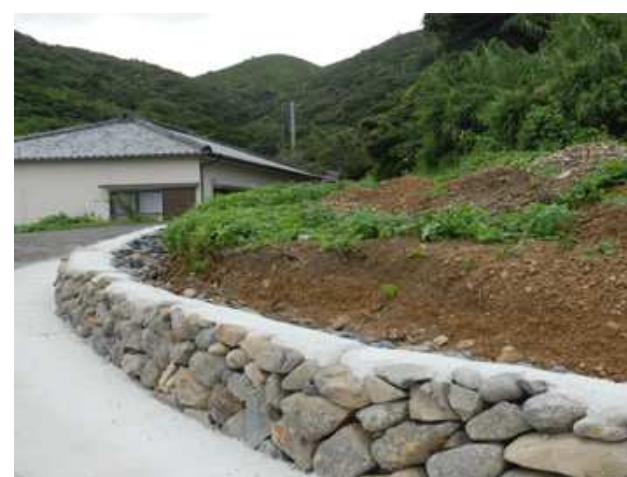
道路建設のための石積み
