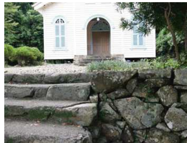
教会建設地の造成のための石積み
