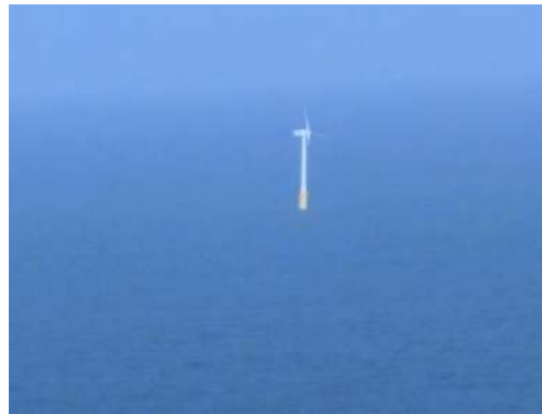
洋上風力発電施設
