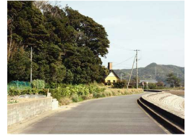
堂崎教会への道路 この先は行き止まりであることの案内が不十分である
