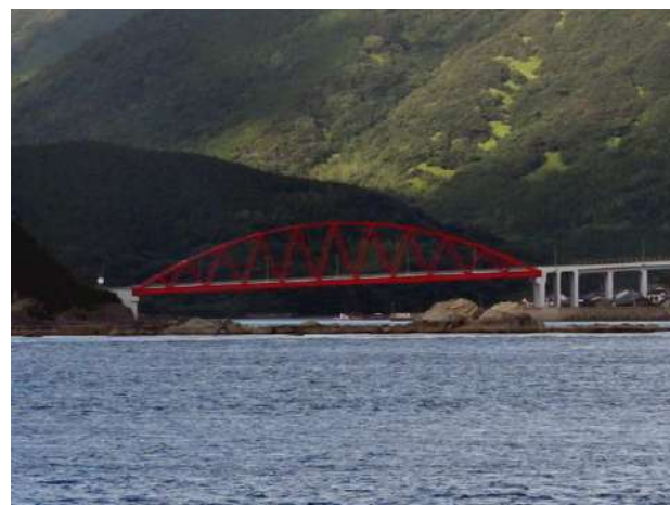
戸岐大橋の側径間
