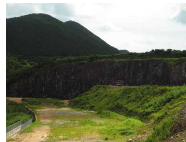
幹線道路から見えない採石場の様子
