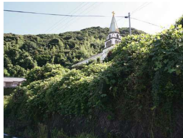
法面の緑化は効果的な手法である
