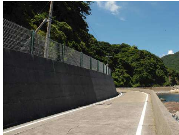
法面整備をともなう海岸道路
