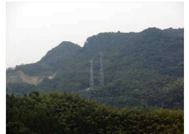
携帯電話の電波塔は眺望の良い場所に設置されやすい
