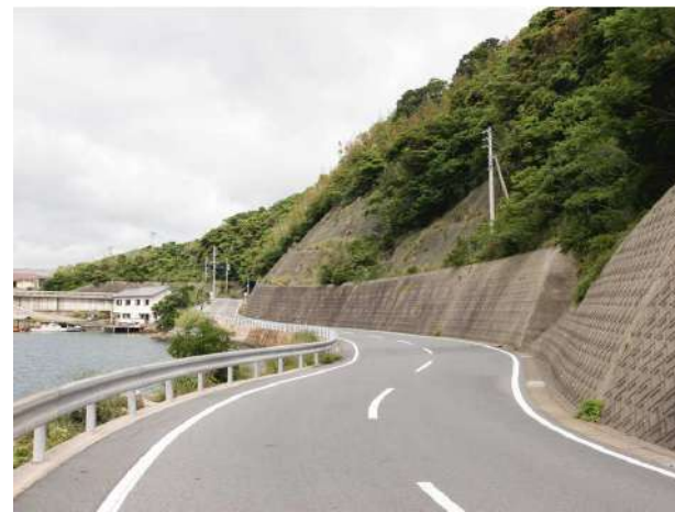
景観上重要なルートでは法面は極力小さくしたい（写真は堂崎教会への道路）
