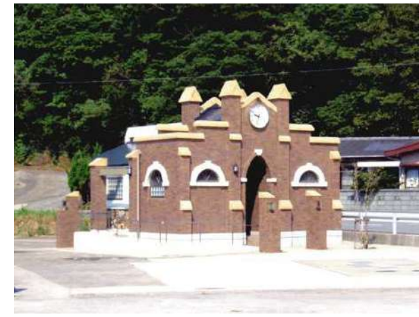
堂崎教会近くのトイレ
