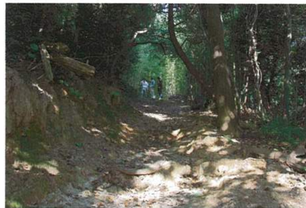
このような急勾配の区間で実験的に整備を行い、現場でデザインの再検討・修正をした上で、全区間を整備する（「見直し」と言う方法）
